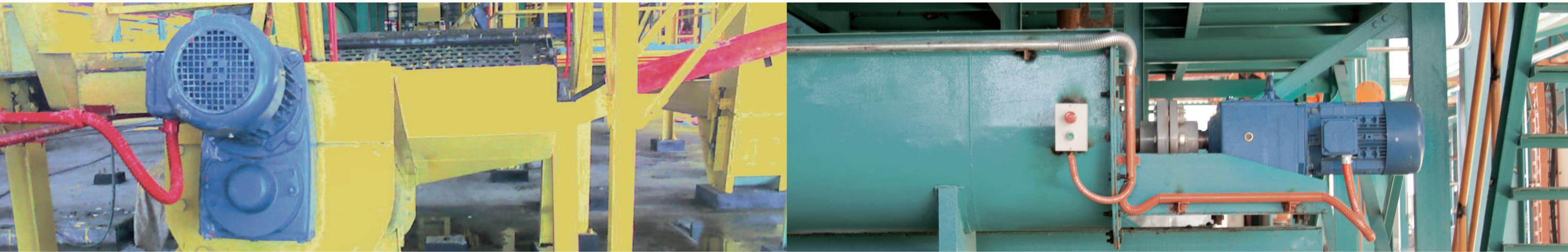
Facile – con la fornitura di motori efficienti e collegati in modo diretto, NORD DRIVESYSTEMS evita l'impiego di trasmissioni esterne a cinghia trapezoidale.
