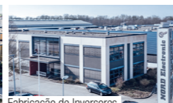
Fabricação de Inversores
