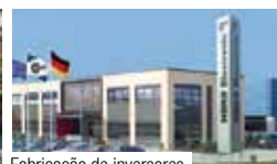
Fabricação de inversores
