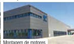
Montagem de motores
